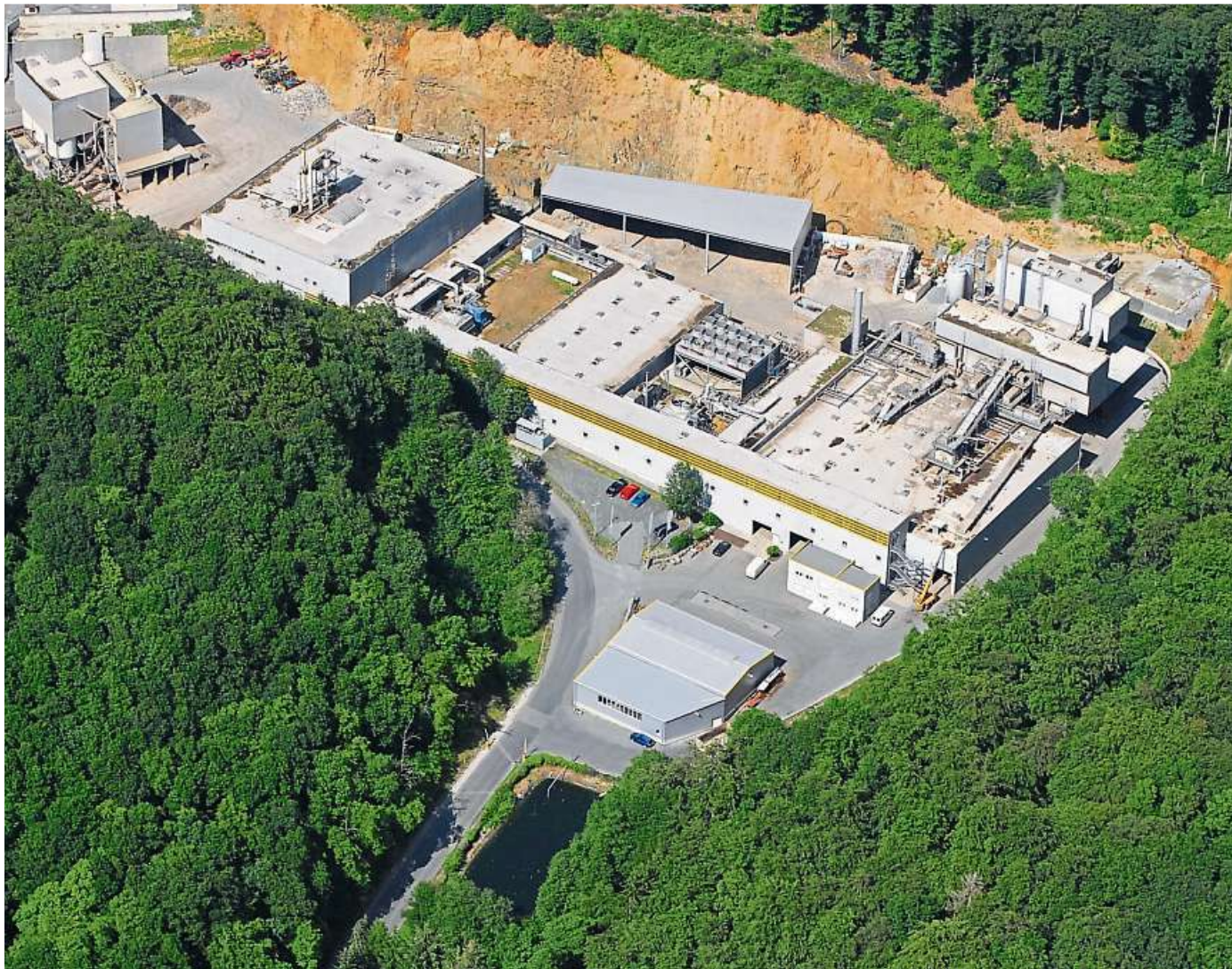
Draufsicht: In Bechlingen bei Aßlar entstand in den 90er-Jahren auf dem Gelände der Abfallwirtschaft Lahn-Dill die erste Trockenstabilatanlage ihrer Art. Die Gebäude sind inzwischen abgerissen oder sie werden anderweitig genutzt. Archivfoto: Abfallwirtschaft Lahn-Dill
